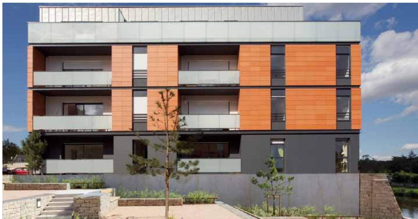
↑ Façade sud-ouest d'un des deux immeubles de logement en accession. Le dessin des façades a été réglé sur le calepinage des bardeaux de terre cuite.
