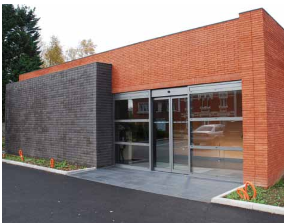
↑ La façade d'entrée est marquée par le jeu de deux couleurs de brique de parement.
